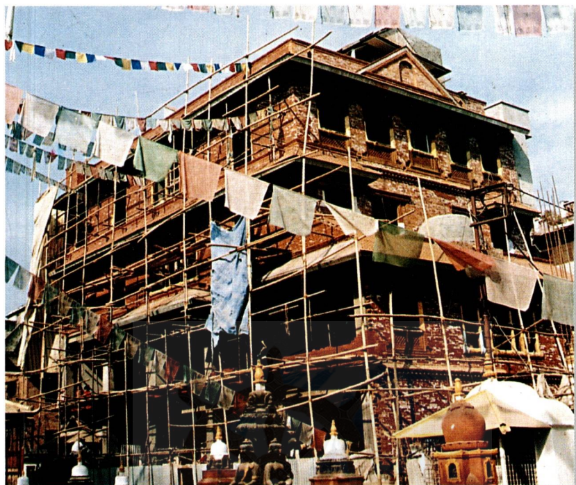
हाल (वि.सं. २०५९) मा नवनिर्मित धर्मकीर्ति विहार भवन निर्माणाधिन अवस्थामा
